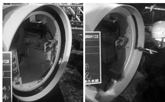
写真-2 掘進機継手箇所TSシール加工状況
