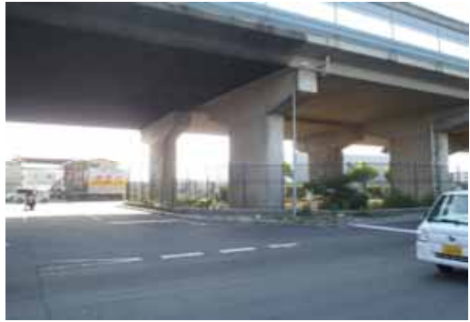
到達部(30R)中央環状線横断部
