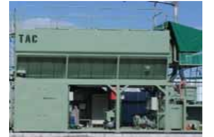
裏込めプラント設置
