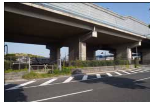
到達部(30R)中央環状線横断部
