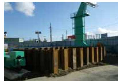
土砂ピット設置 (鋼矢板 型)
