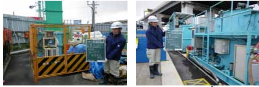
濁水処理プラント設置
