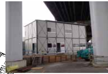
工事事務所設置
