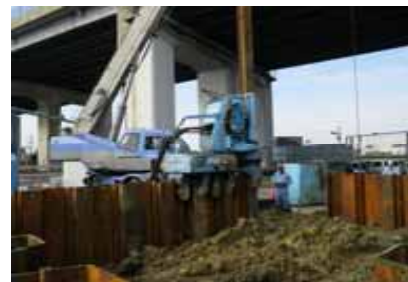
土砂ピット設置 (鋼矢板 型)
